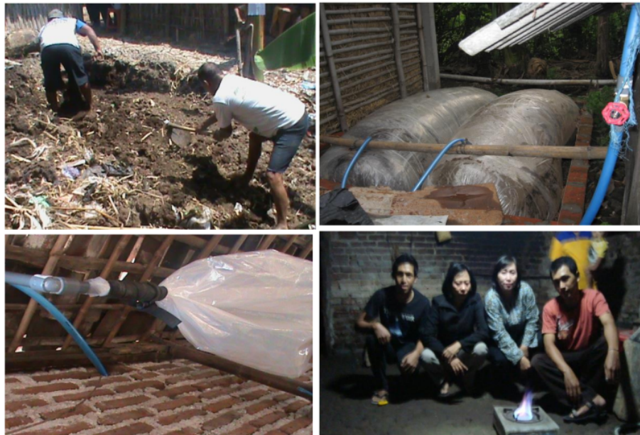
Gambar 3. Pembuatan Instalasi Biogas
